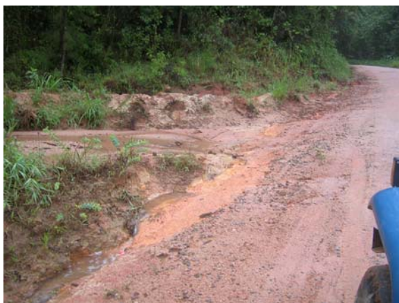
Foto 23: saída de água com função de evitar processos erosivos ocasionados por enxurradas nos cantos da estrada. No detalhe percebe-se que tal intervenção não está contendo o volume de água proveniente dos trechos mais altos da via, tanto que abaixo vê-se o excedente escoando e cavando caminhos ao longo do canto.
