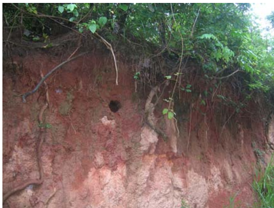
Fotos 21: barranco lateral da estrada de acesso que sofre constantes deslizamentos em razão da raspagem realizada para alargar a via. Detalhe para o ninho de Pica-pau do campo correndo risco de desabamento.
