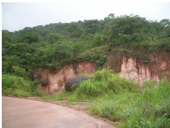
Foto 22: Talude de solo retirado da encosta da Serra do Itapetinga às margens da estrada de acesso à laje da Pedra Grande para manutenção da mesma. A prática, além impactar visualmente o cenário, intensifica processos erosivos e de intemperismo físico no local em destaque e colabora para o desbarrancamento do solo disposto imediatamente acima do corte.
