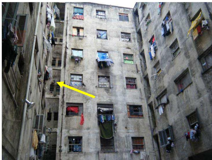
**Figura 70: destaque do espaço para a possível passagem de prumada ascendente**
