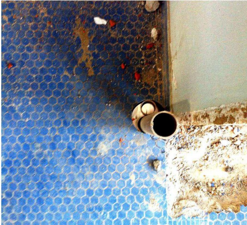
**Figura 97: Solução para Tubulações com perfuração da laje - detalhe de obra visitada pelo grupo. Fonte: elaboração própria.**
