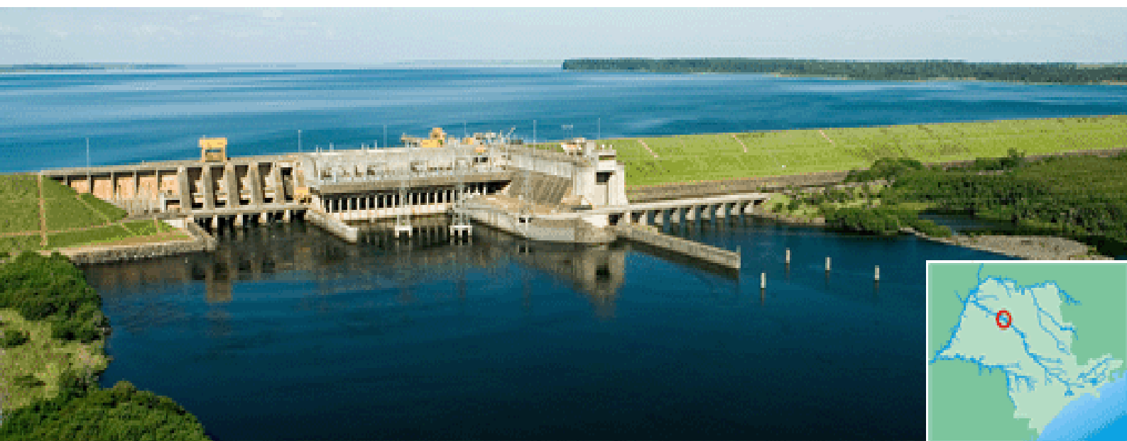
Foto 10. Usina Hidrelétrica de Promissão
