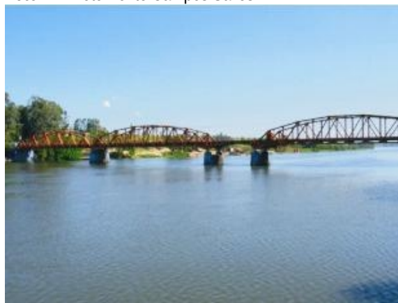
Foto 21 - Foto Ponte Campos Salles
