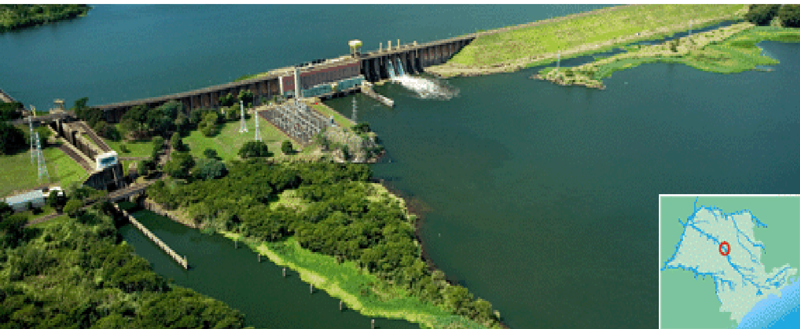
Foto 9. Usina Hidrelétrica de Ibitinga
