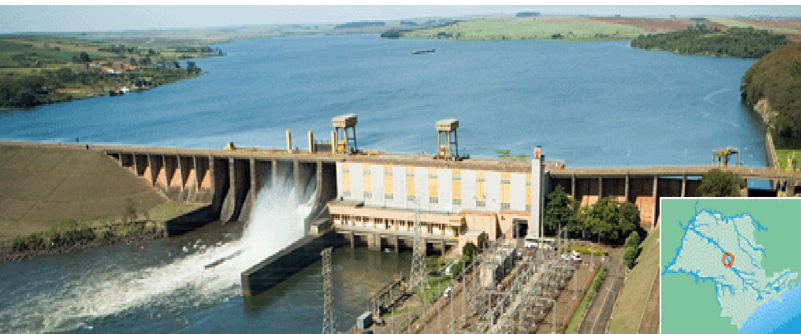
Foto 8. Usina Hidrelétrica de Bariri
