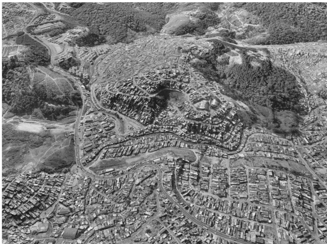
Figura 9 – Visão geral do Parque Corumbé/Parque Linear do Bananal e entorno - antes
