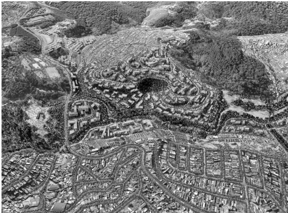
Figura 10 – Visão geral do Parque Corumbé/Parque Linear do Bananal e entorno – depois
