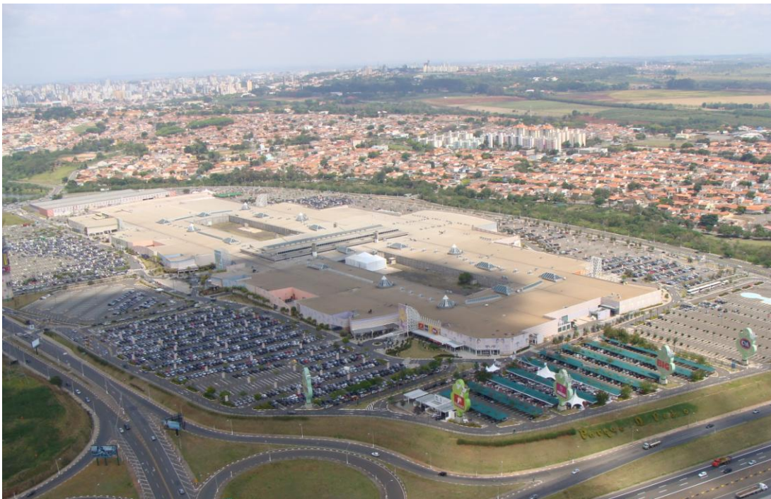
Figura 74. Vista de imenso shopping center em Campinas, a implantação segue o padrão verificado em empreendimentos análogos no mundo inteiro. Deseja-se o consumidor, mas acolhe-se, com controle e limite, parte da vida pública contemporânea. Foto: Acervo QUAPÁ, 2008.
