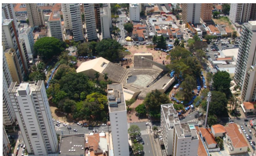
Figura 34. Vista aérea do Centro de Convivência de Campinas, implantado na Praça Imprensa Fluminense, projeto complexo, espaço híbrido, sobreposição de tempos, histórias e memórias. Foto do autor, 2008.
