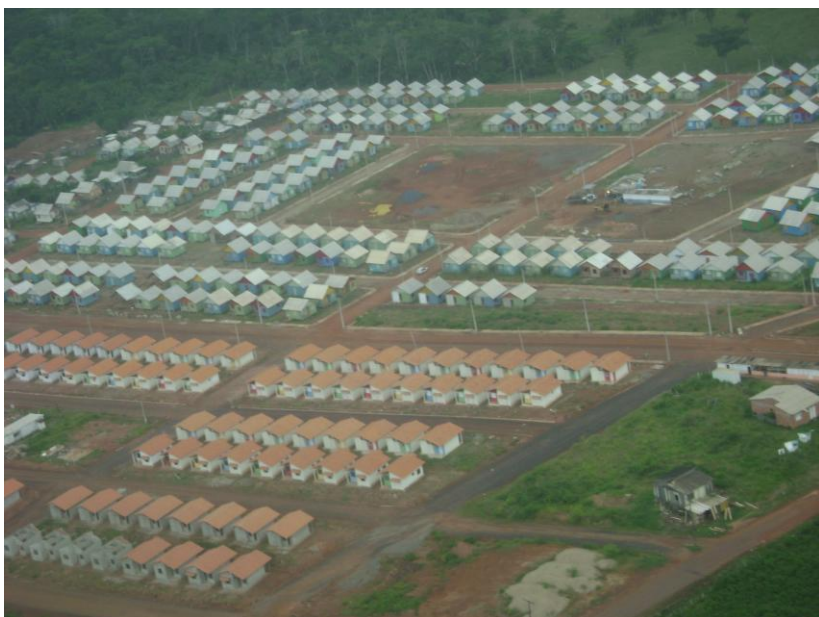
Figura 79. Vista de um conjunto habitacional em Rio Branco, pouco se avançou a partir da ditadura militar na qualidade da produção de habitações de interesse social. Foto do autor, 2011
