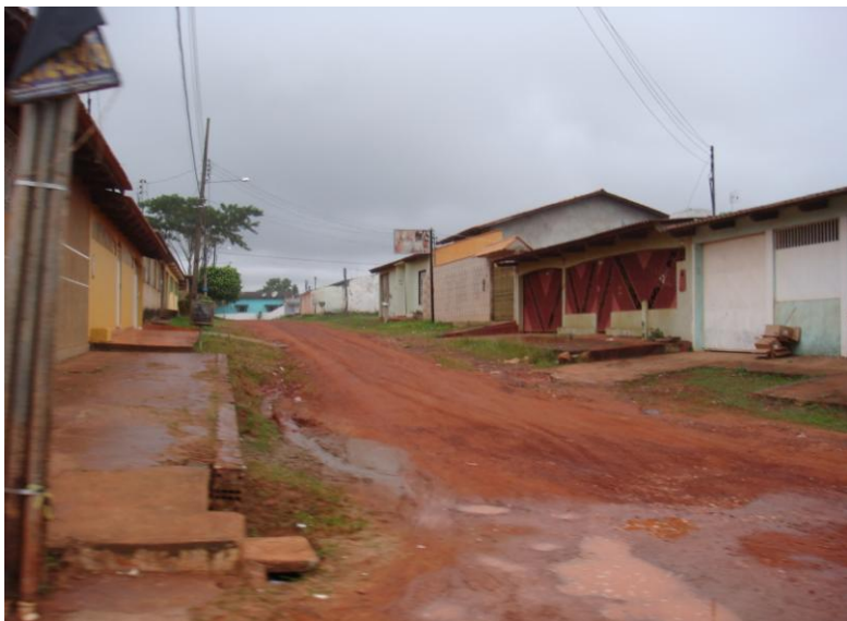
Figura 17. Calçadas irregulares realizadas pelos moradores em Rio Branco, observe-se que a municipalidade sequer implantou o meio-fio. Foto do autor, 2011.
