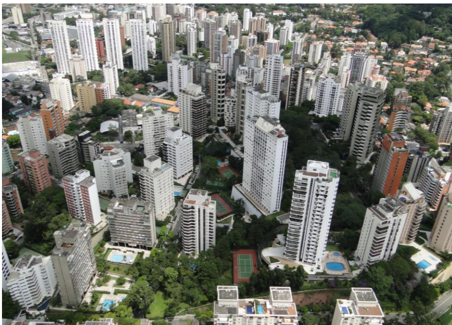
Figura 75. Edifícios residenciais e suas áreas de lazer na Vila Andrade, São Paulo. Isolamento em relação ao entorno público. Foto: Fabio Gonçalves, 2012.
