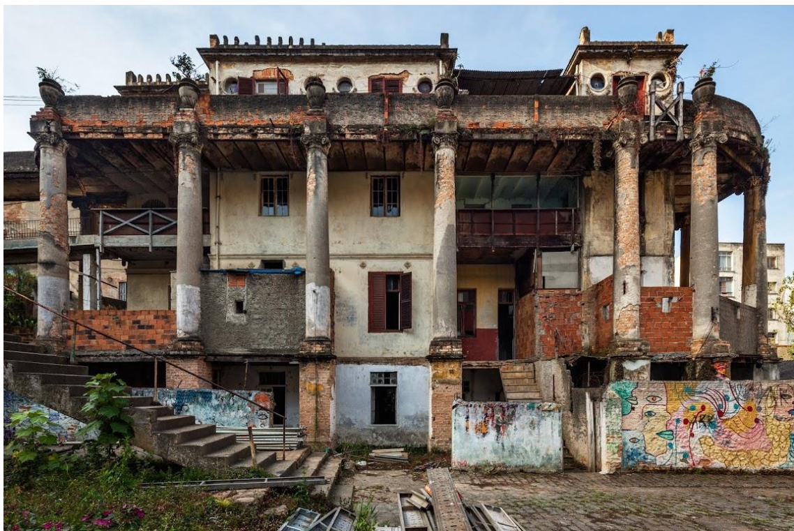
Figura 3: Vila Itororó | Vista lateral do Palacete. Foto: Nelson Kon. Fonte: Vila Itororó, Canteiro Aberto, 2014.
