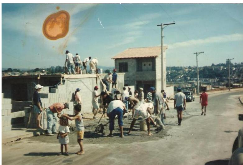
**FOTOGRAFIA 25 – Mutirão carregando concreto nas latas para encher as lajes**
