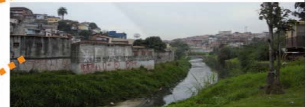
Vista Geral Construção avançam sobre o Ribeirão Perus Vista do centro em direção ao recanto dos girassóis
